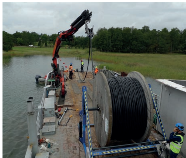
Vesistökaapelin asennustyö käynnissä Saaristomerellä
